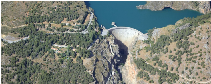
Presa de Quéntar
