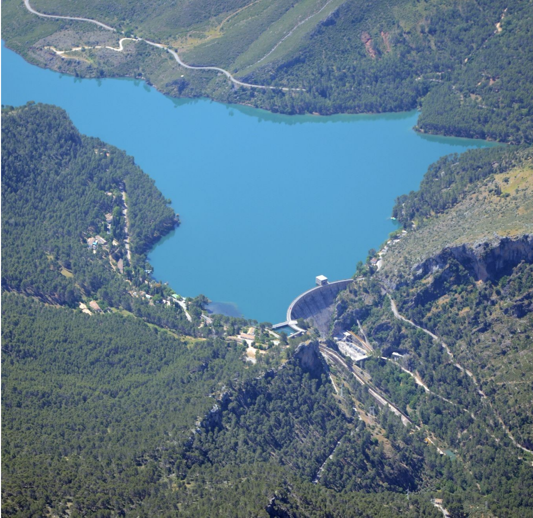
Presa de Tranco de Beas
