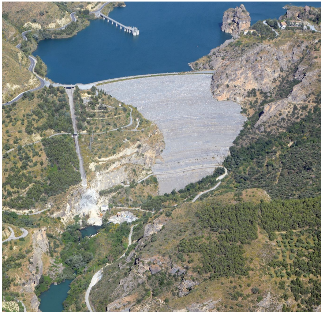
Presa de Canales
