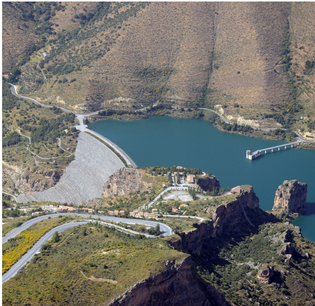
Presa de Canales
