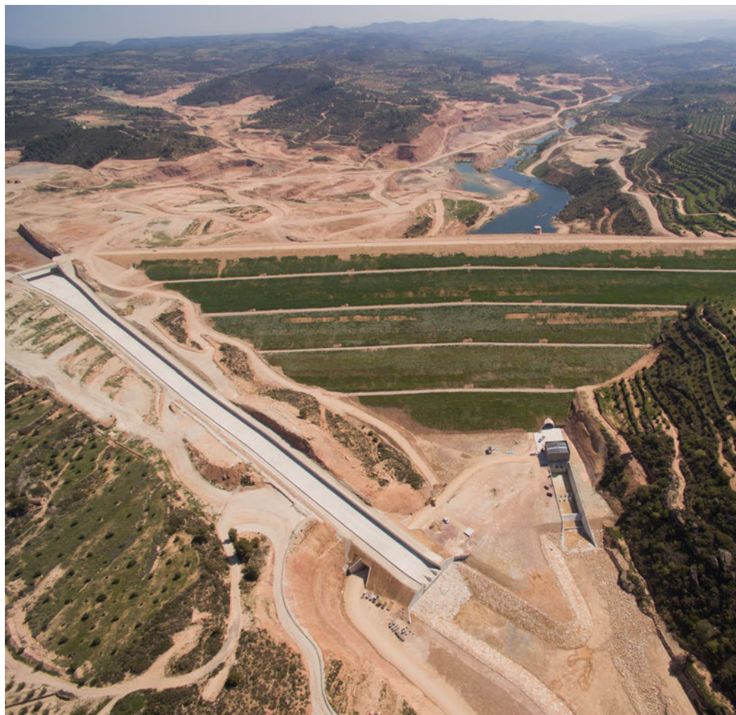
| Presa de Albagés
