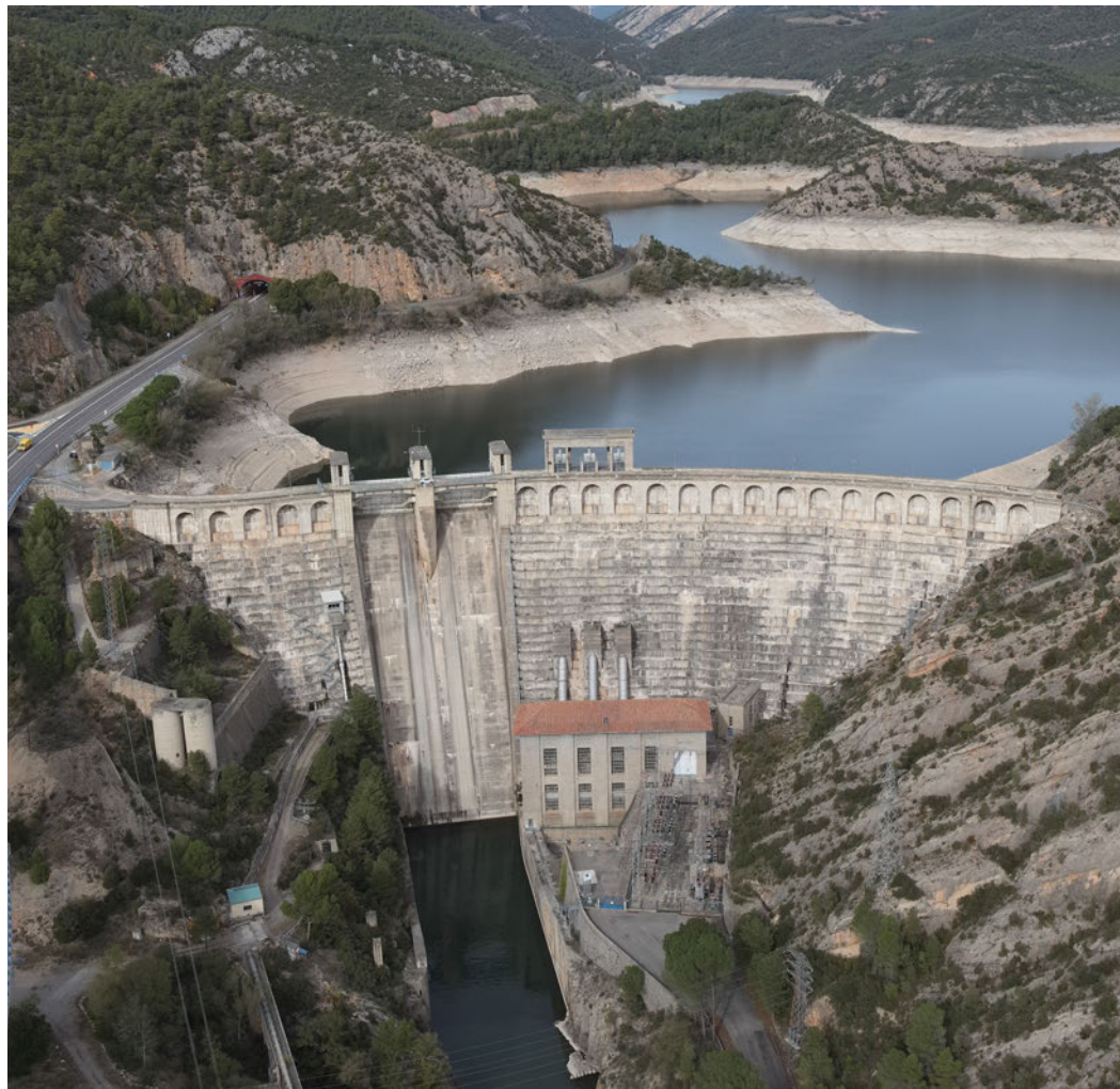
Presa de Oliana
