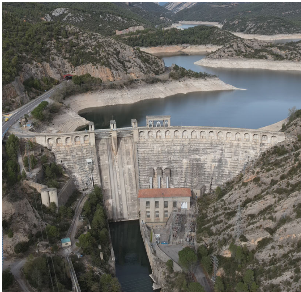
Presa de Oliana
